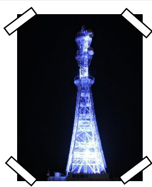
東北電力 鉄塔ライトアップ
