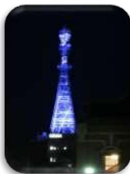
東北電力 鉄塔ライトアップ
